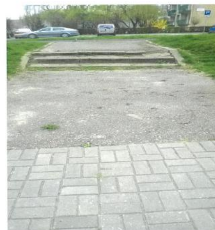
Środkowa część chodnika ze schodami widok od strony bloków
